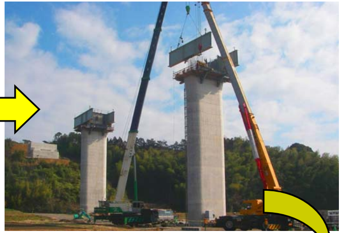
②橋脚位置(柱頭部)に鋼桁を架設
