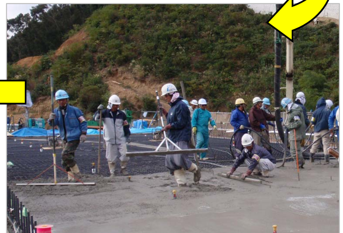
③ トンボを用いてコンクリート表面を仕上げる
