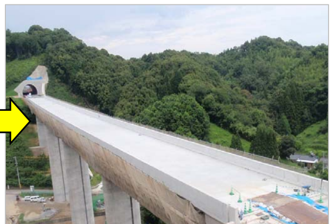
⑥ 床版工完了 (舗装工事へ引き渡し)
