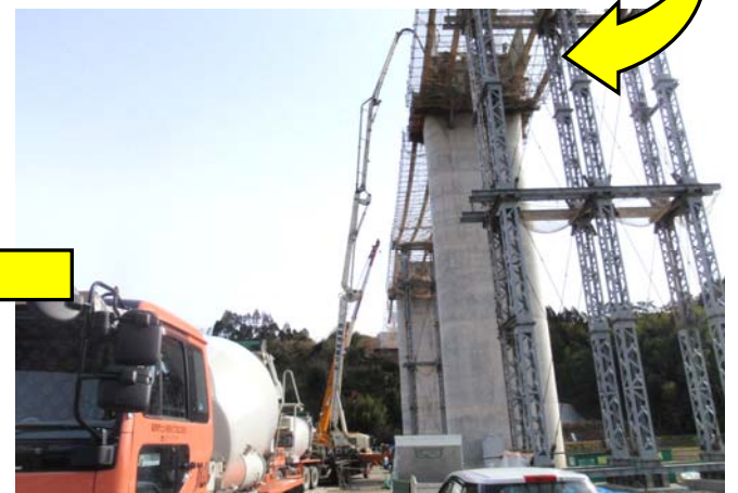
③コンクリートで鋼桁とRC橋脚を一体化
