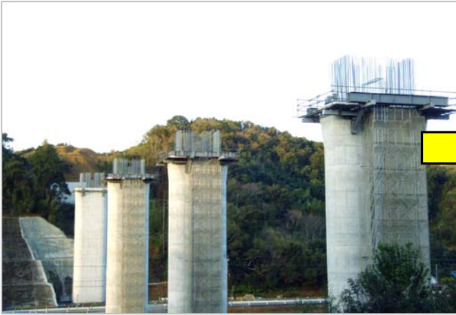
①RC橋脚を施工した下部工業者から引継ぎ
