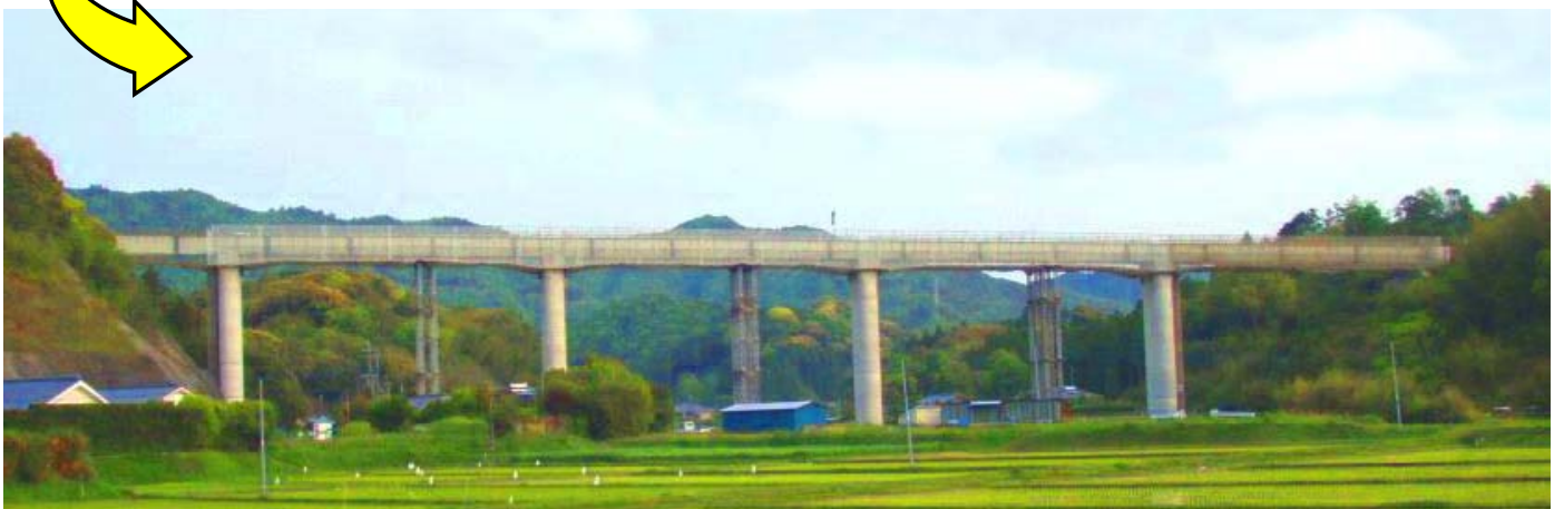
⑤鋼桁架設完了、床版工(次頁)へ
