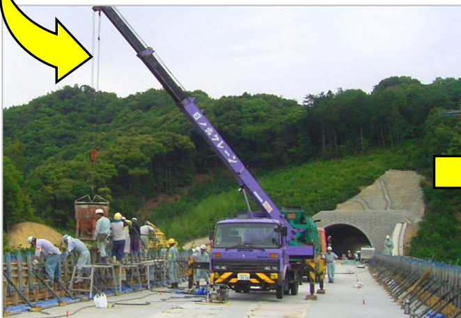
⑤ 壁高欄コンクリートを打設
