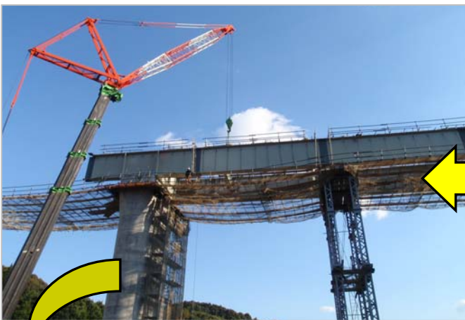
④柱頭部以外の鋼桁を架設
