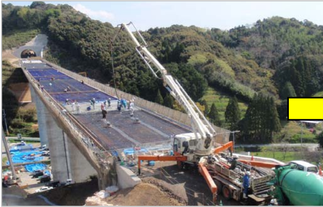
① 鋼桁上に足場・型枠・鉄筋を設置し、 床版コンクリートを打設
